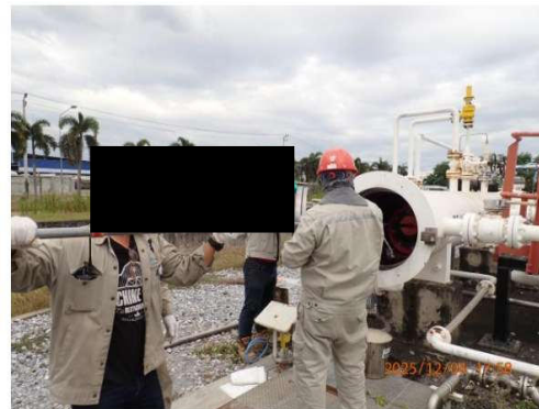
รูปที่ 2-2 การทำความสะอาดท่อส่งน้ำมันด้วย Cleaning Pig
